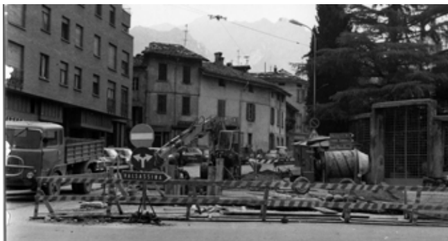
Lavori all'incrocio di Corso Matteotti - XI Febbraio - Giovanni XXIII
